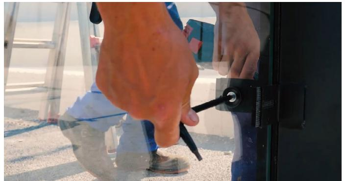
Les parois vitrées doivent être parfaitement fixées à la structure résistante, mais sans entrer en contact direct avec celle-ci. Pour ce faire, il convient d'utiliser des séparateurs en néoprène ou en caoutchouc d'une épaisseur de 5 à 8mm.
